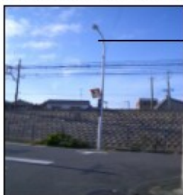
防犯灯 新設 (東雲東)
